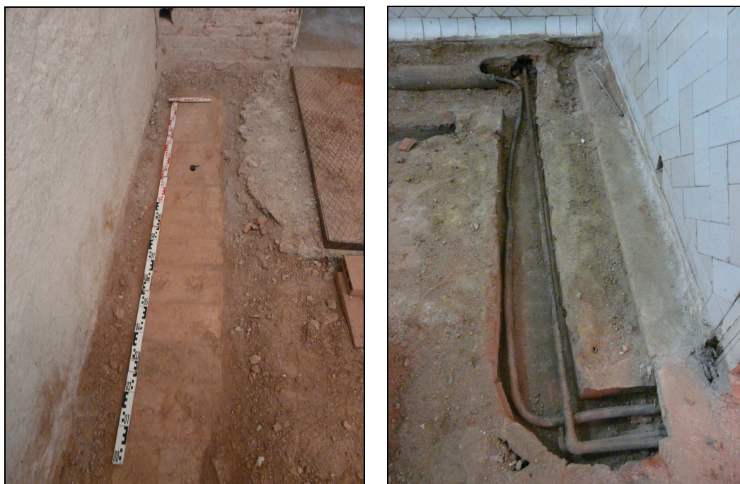
Fig. 10 i 11.- Vista del tipus més habitual de canalització de serveis. A l'esquerra amb la coberta de rajola, a la dreta un cop extreta la coberta. S'observen els tubs de serveis a l'interior.
