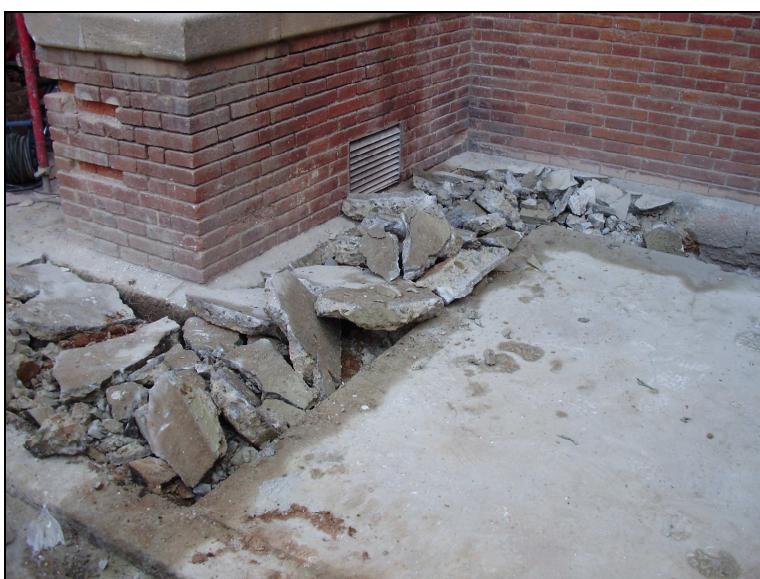
Fig. 19.- Procés d'obertura de la rasa perimetral.
