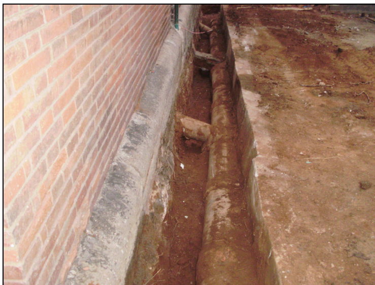
Fig. 22.- Vista general del tub u.e. 123 amb els tubs 124, 125 i 126.
