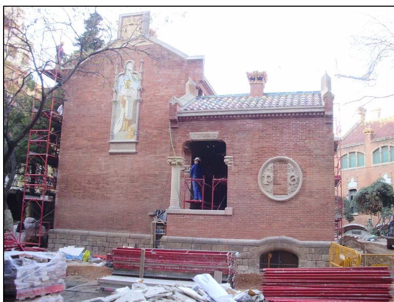
Fig. 18.- Vista de La façana meridional del Pavelló de Santa Apol·lònia.
