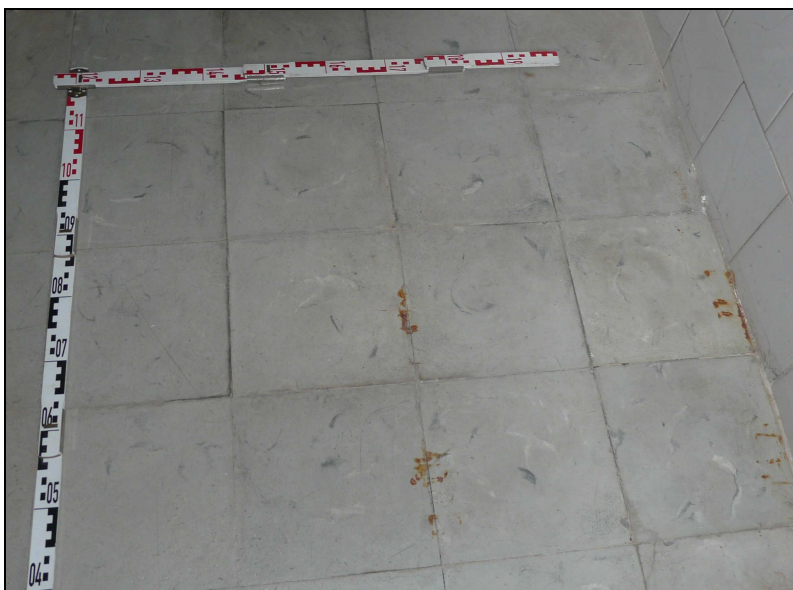
Fig. 9.- Detall del paviment hidràulic corresponent a la reforma de finals de la dècada dels 50 del segle XX que pavimenta el corredor central i les estances de la banda nord est del pavelló.
