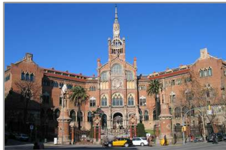
Vista de la façana de l' accés sud de l' hospital
