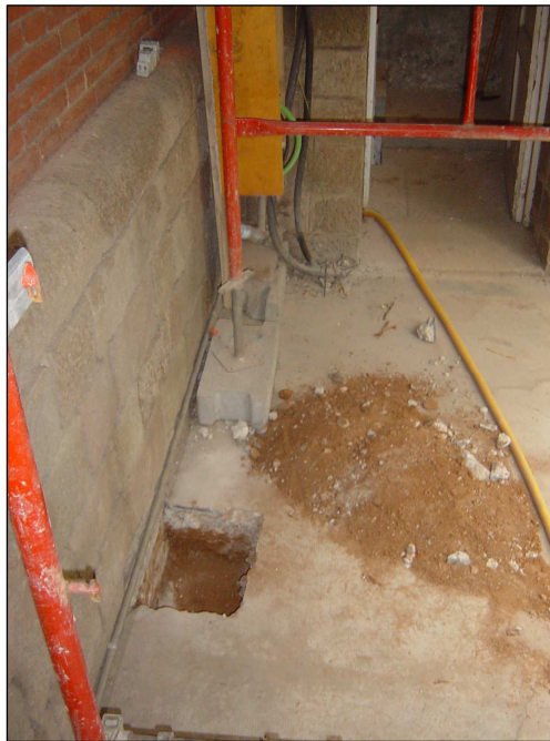
Fig. 7.- Vista general del sondeig 9.
