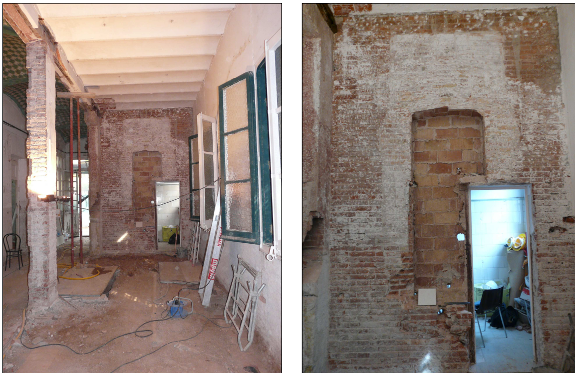
Fig. 15 i 16.- Vista de la zona que es va incorporar al pavelló després de la reforma de mitjan segle XX. Al fons s'observa la traça de l'antiga finestra. A la foto de la dreta, detall d'aquesta traça.
